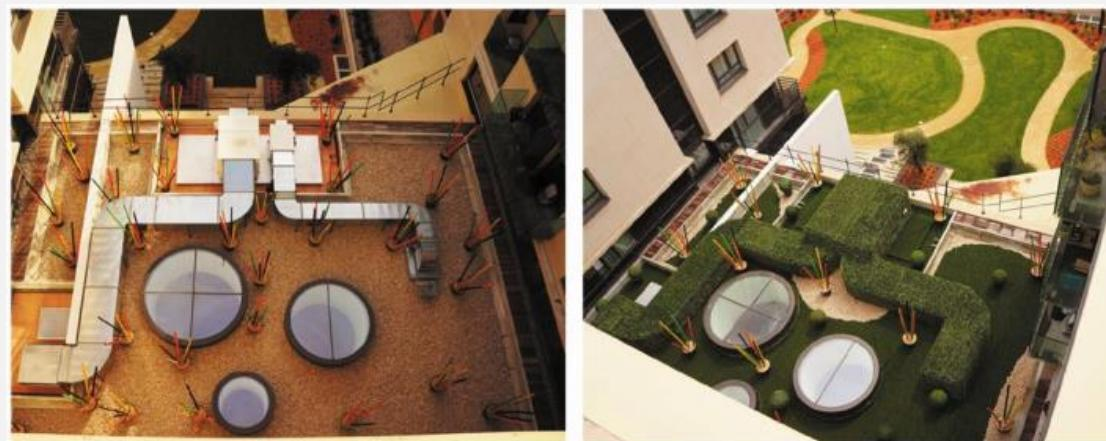
Une solution esthétique pour cacher vos climatiseurs, pompes à chaleur, gaines d'aérations, tuyauteries. L'air circule librement, comme avant. Des solutions efficaces en toitures techniques, aucun besoin de percer ou de toucher à l'étanchéité.
